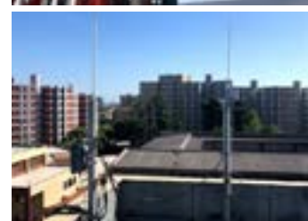
Gateways LoRa instalados no ISEL e nas Amoreiras
