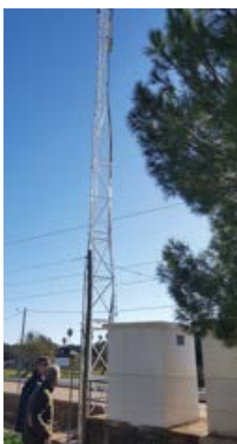
A realizar trabalhos de inspeção e certificação de sistemas de comunicações ferroviárias
