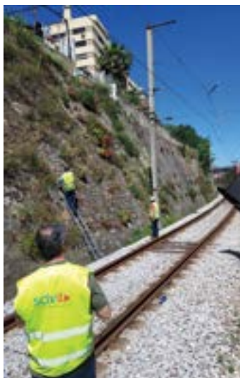
A acompanhar trabalhos de instalação de equipamento de sensorização e comunicação em taludes Ferroviários
